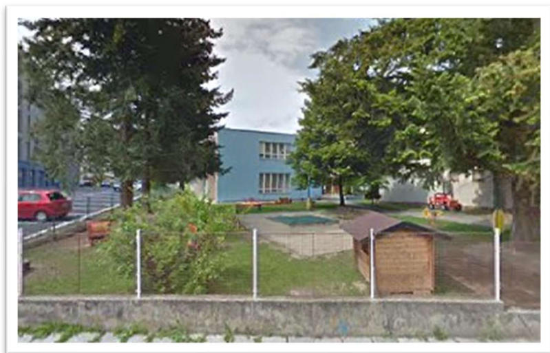
Obrázek č. 44: Fotografie budovy mateřské školy
