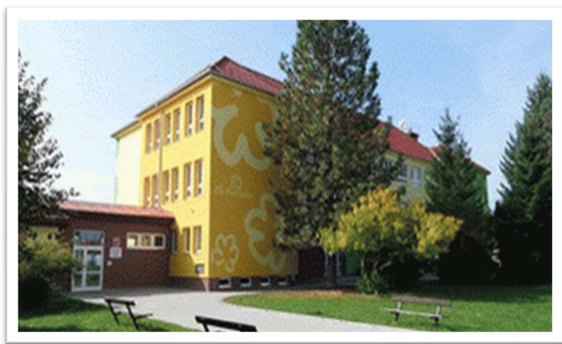
Obrázek č. 31: Fotografie budovy mateřské školy
