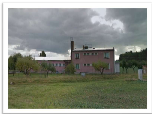
Obrázek č. 28: Fotografie budovy mateřské školy
