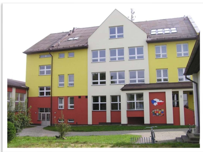
Obrázek č. 35: Fotografie budovy mateřské školy
