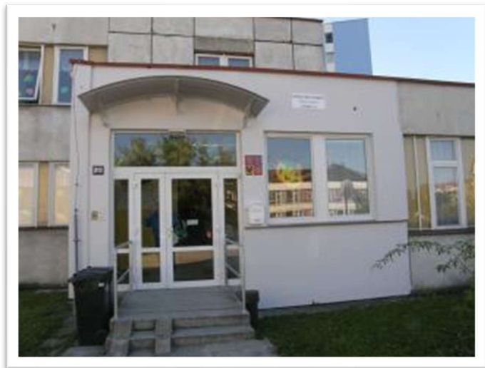
Obrázek č. 45: Fotografie budovy mateřské školy
