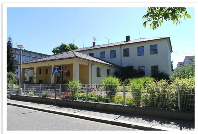
Obrázek č. 42: Fotografie budovy mateřské školy
