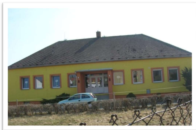
Obrázek č. 36: Fotografie budovy mateřské školy
