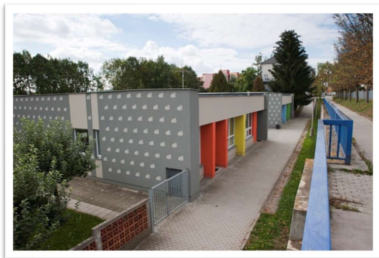
Obrázek č. 41: Fotografie budovy mateřské školy
