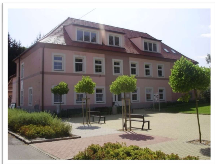
Obrázek č. 32: Fotografie budovy mateřské školy
