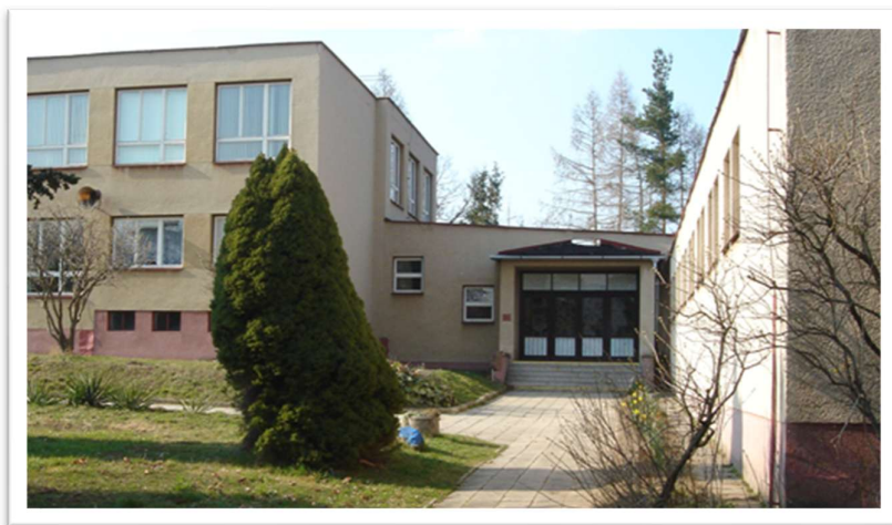
Obrázek č. 30: Fotografie budovy mateřské školy
