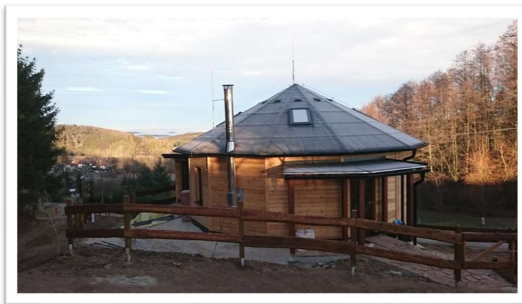
Obrázek č. 50: Fotografie budovy mateřské školy
