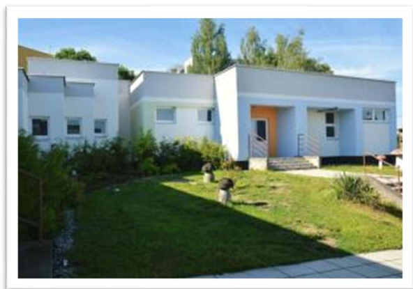
Obrázek č. 46: Fotografie budovy mateřské školy
