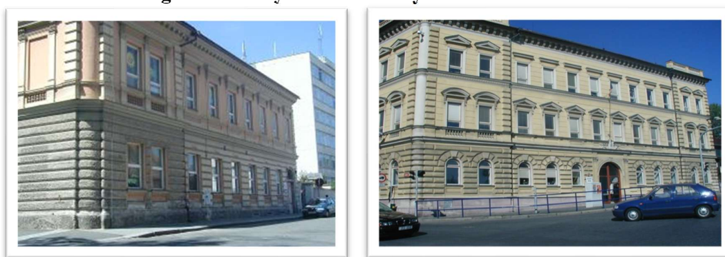
Obrázek č. 39: Fotografie budovy mateřské školy
