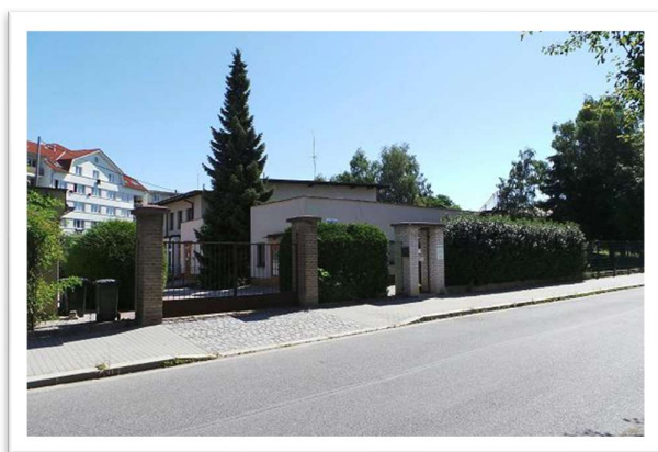
Obrázek č. 37: Fotografie budovy mateřské školy
