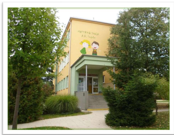
Obrázek č. 40: Fotografie budovy mateřské školy
