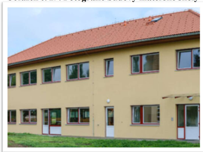
Obrázek č. 29: Fotografie budovy mateřské školy
